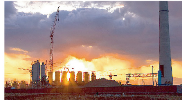
台城电厂蒸汽首站 Baicheng power plant
