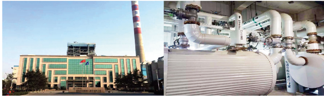
国电京阳煤电一体化 State Power Ying Yang coal integration
